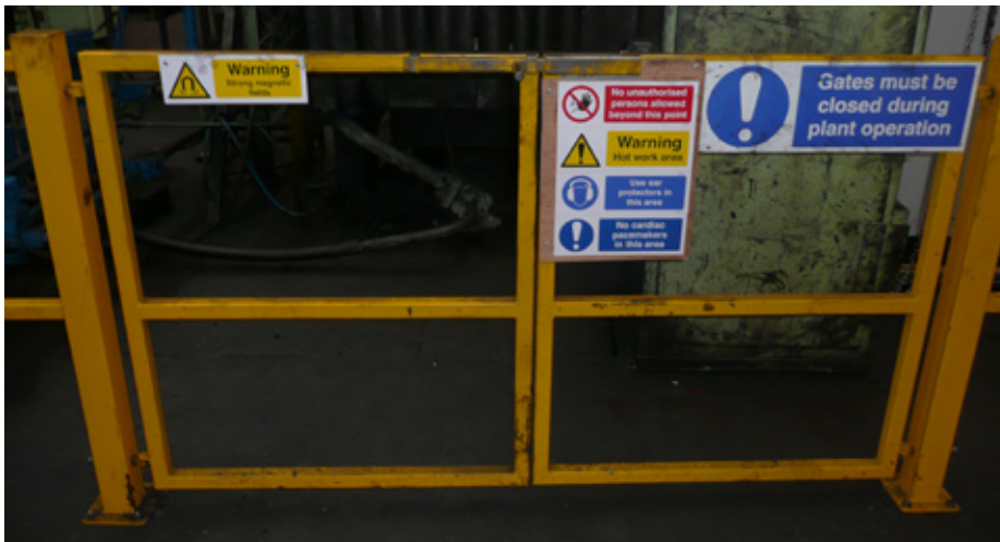
Figura 9.1 — Exemplo de uma guarda amovível simples usada para restringir o acesso a um campo magnético forte. Neste caso, a guarda não está bloqueada, mas é complementada por sinais de aviso e medidas organizativas
