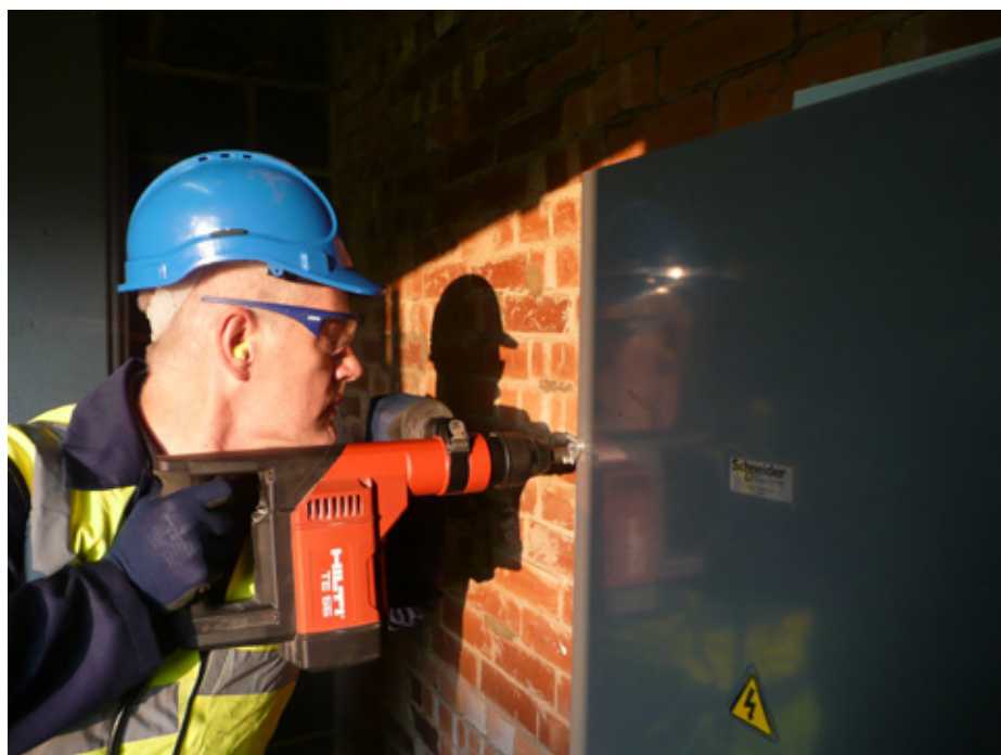
Figura 6.5 — Trabalhador com uma ferramenta elétrica segurada perto do corpo. Nesta situação, a exposição do corpo e dos membros será similar e o cumprimento dos NA baixos/altos terá limitações
