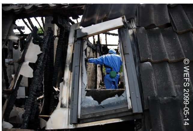
Trabalho de remoção de amianto após um incêndio
