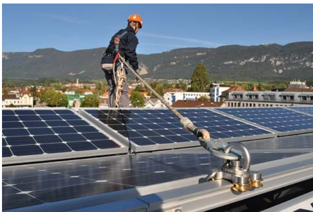
Fig. 9 Système de retenue
