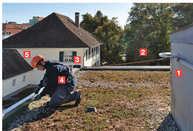
Fig. 11 Système de retenue sur un toit plat
