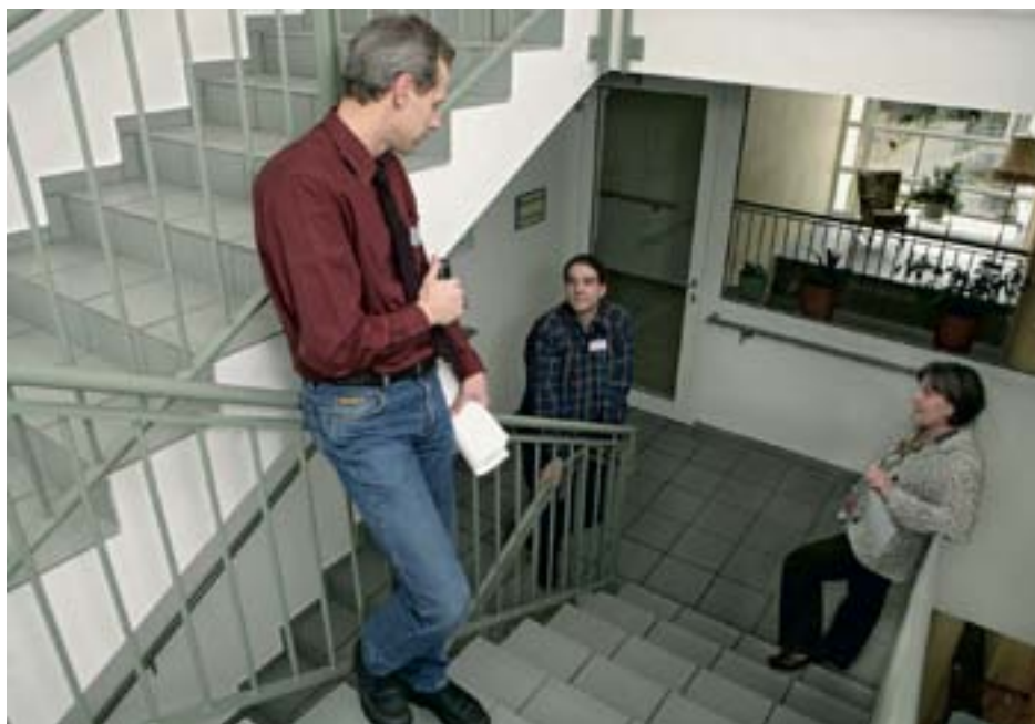
44 Cage d'escalier: des sols appropriés en bon état, une main courante continue et un éclairage optimal sont les conditions essentielles de la prévention des accidents de plain-pied.
