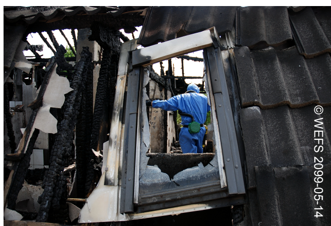
Travaux d'enlèvement de l'amiante après un incendie
