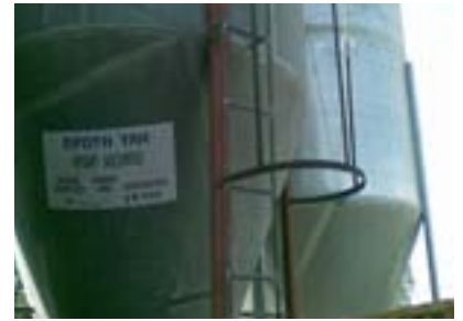
Entrée d'un espace confiné.
