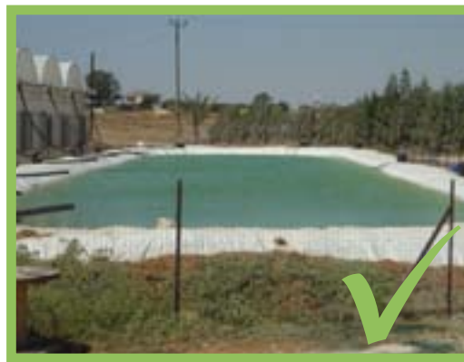
Installez des clôtures, ou tout autre dispositif similaire, pour bloquer l'accès aux réservoirs d'eau, aux tranchées et aux fossés.
