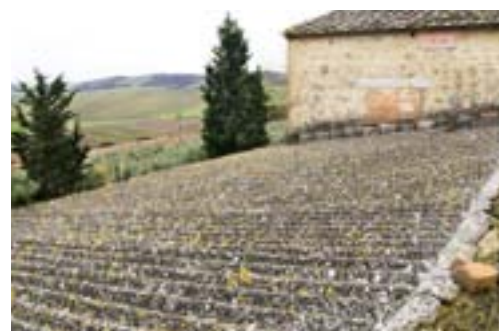
Les toitures en bon état peuvent rester en place.
